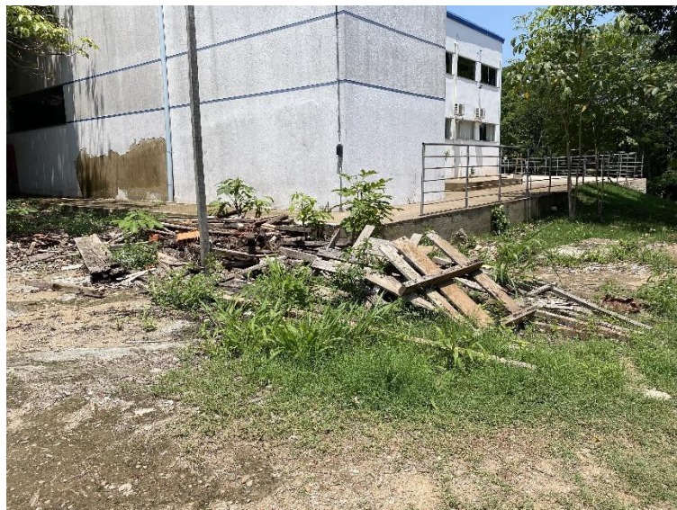
Foto 4 – Remoção de entulho.
