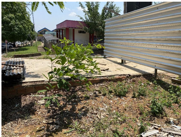
Foto 7 – Remoção de entulho.
