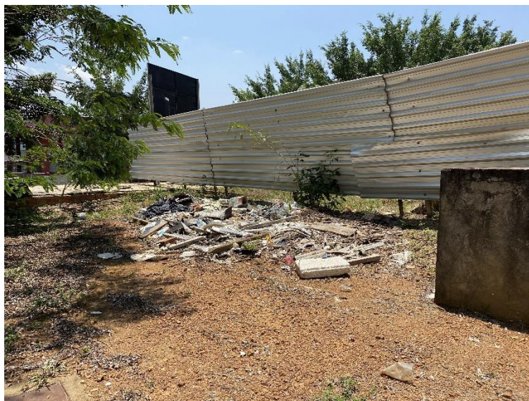
Foto 6 – Remoção de entulho.
