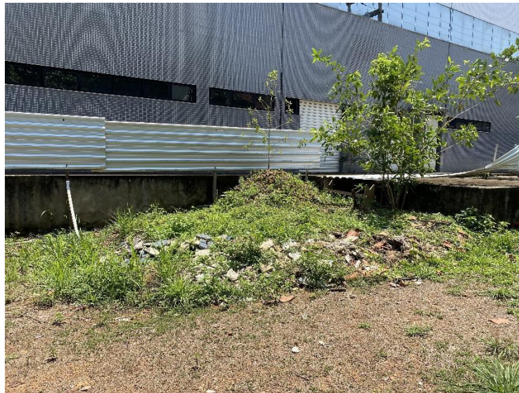
Foto 3 – Remoção de entulho.
