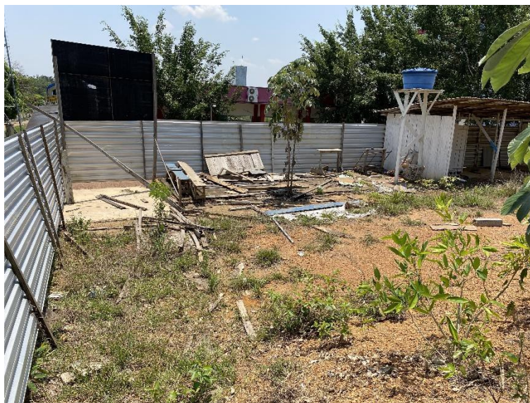
Foto 8 – Remoção de entulho.
